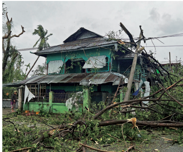
5月14日，在缅甸若开邦皎道，当地人查看受损的建筑。据缅甸国家管理委员会14日公开的消息，热带气旋“穆查”当日上午从孟加拉湾登陆缅甸西部若开邦。“穆查”以每小时209千米的风速袭击了孟加拉国和缅甸沿海地区，对多地基础设施造成破坏，并造成人员伤亡。新华社/法新
