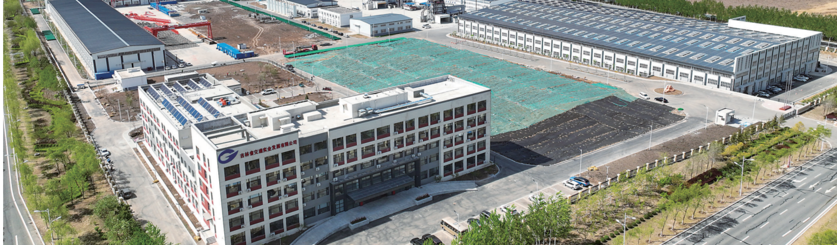
日前,由中国铁建大桥工程局集团承建的吉林省交通材料产业园(二期)项目正式投入使用。今后,产业园将通过对新设备、新工艺的研发,以更符合市场需求的新产品代替传统的交通材料,填补我省交通建设材料产业空白。
