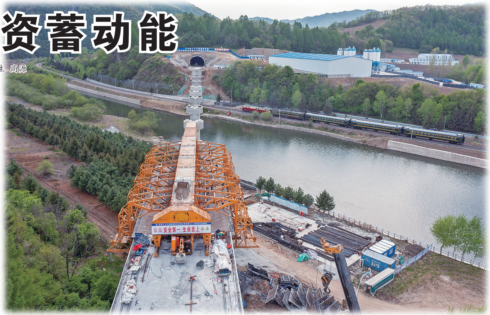
中铁二十三局集团承建的沈白高铁吉林段TJ-6标汤河3号大桥，跨越铁路、公路、河流及水库，施工难度大、安全风险高，施工单位攻坚克难，严把安全质量关，工程进展顺利。图为正在进行移动模架钢筋绑扎作业。 陈扬 杨景霜 摄
