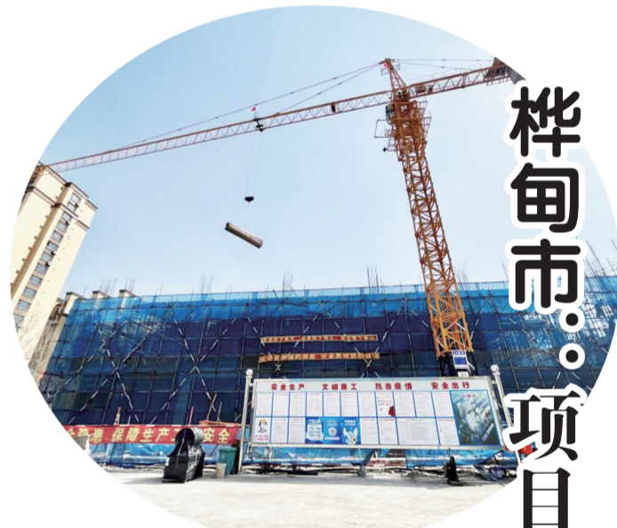
桦甸市华宇国际酒店综合体项目建设基地施工现场。
