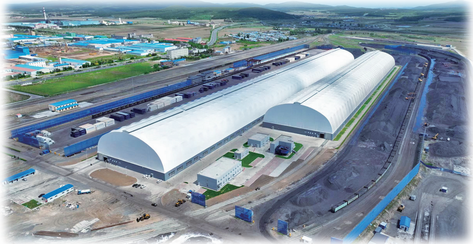
总投资5.9亿元的珲春市进口百万吨煤炭产业园项目竣工。殷雨 摄
