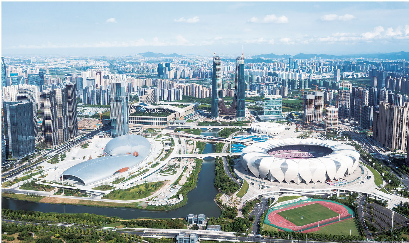
2021年8月2日拍摄的杭州奥体中心场馆群(无人机照片)。
