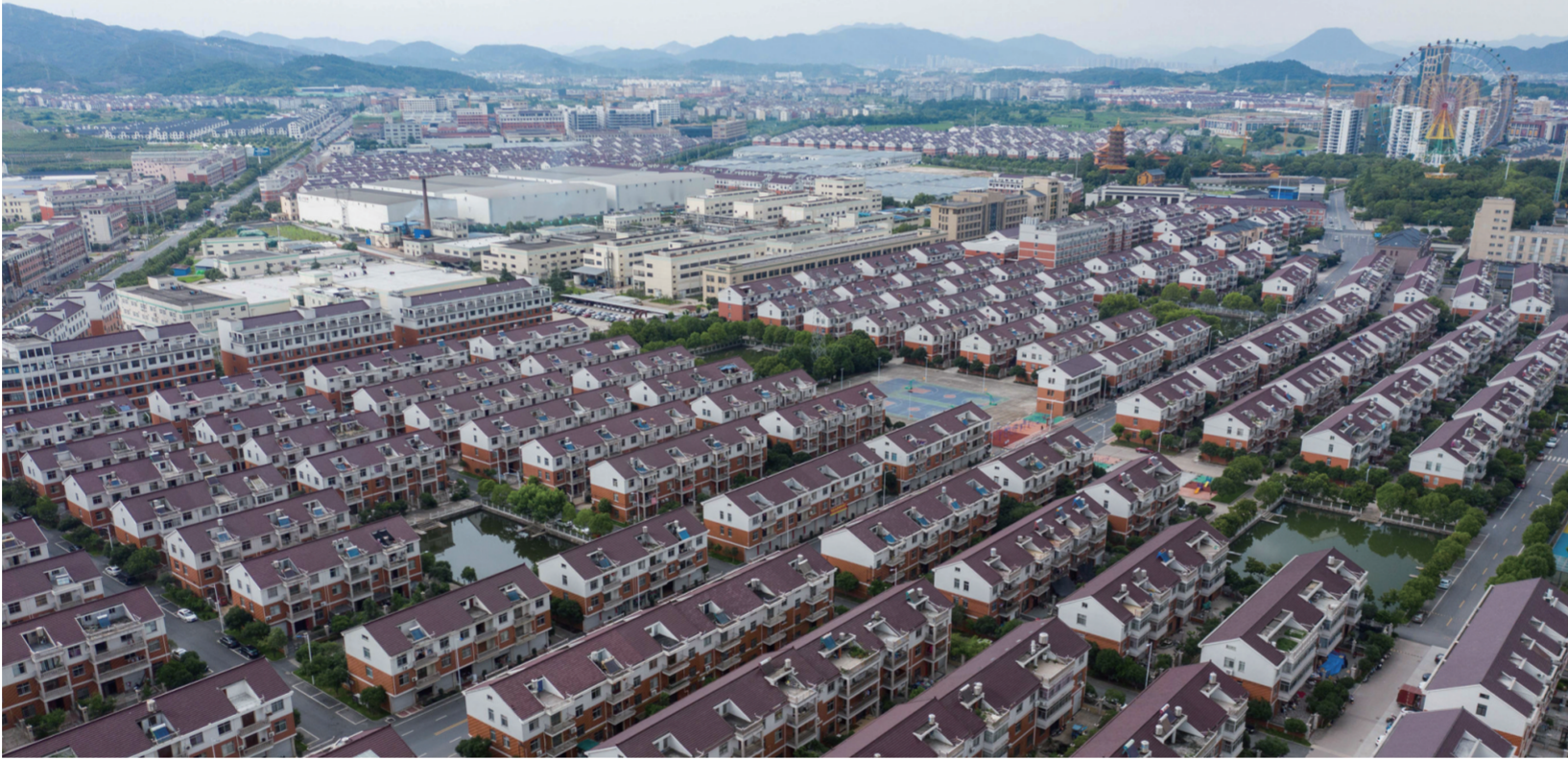
6月19日拍摄的花园村农民新居(无人机照片)。
