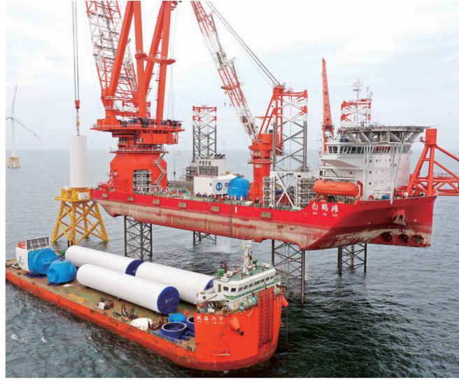
6月24日，施工人员在“白鹤滩”号海上风电安装平台上吊装塔筒(无人机照片)。当日，在福建平潭外海，全球首台16兆瓦大容量海上风电机组开始安装。
