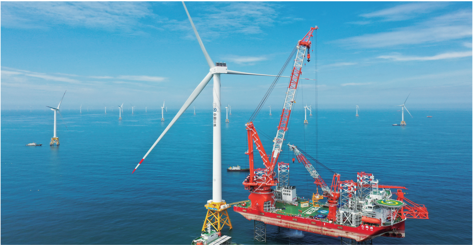
6月28日拍摄的全球首台16兆瓦海上风电机组吊装现场(无人机照片)。
