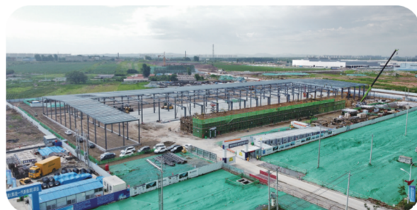
麦格纳新能源电池盒及车身、底盘类产品项目施工现场。
