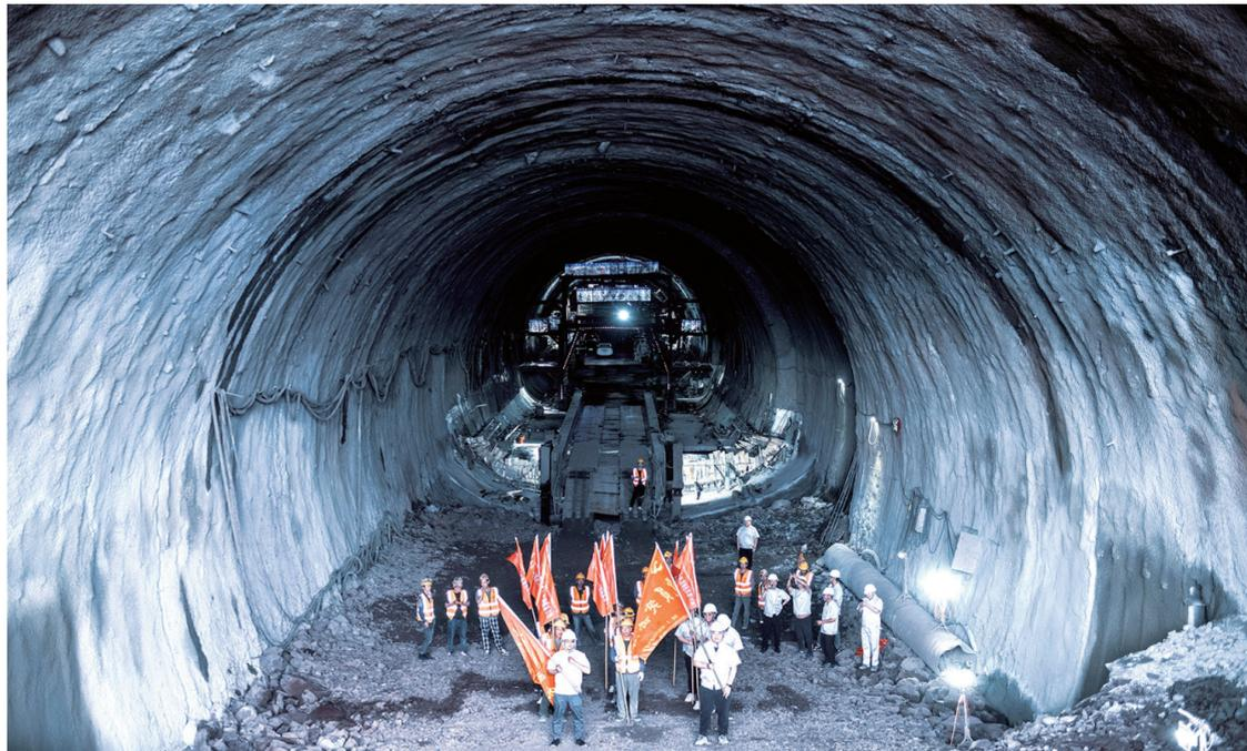
7月5日,由中铁二十三局集团承建的沈阳至白河高速铁路吉林段TJ-6标赤松隧道顺利贯通。隧道位于白山市江源区湾沟镇境内,为单洞双线隧道,全长1553米,最大埋深约100米。开工建设以来,项目部不断优化资源配置,以“短、紧、快、勤”的模式,高标准、细管控,保安全、强管控,全力推动工程建设。
