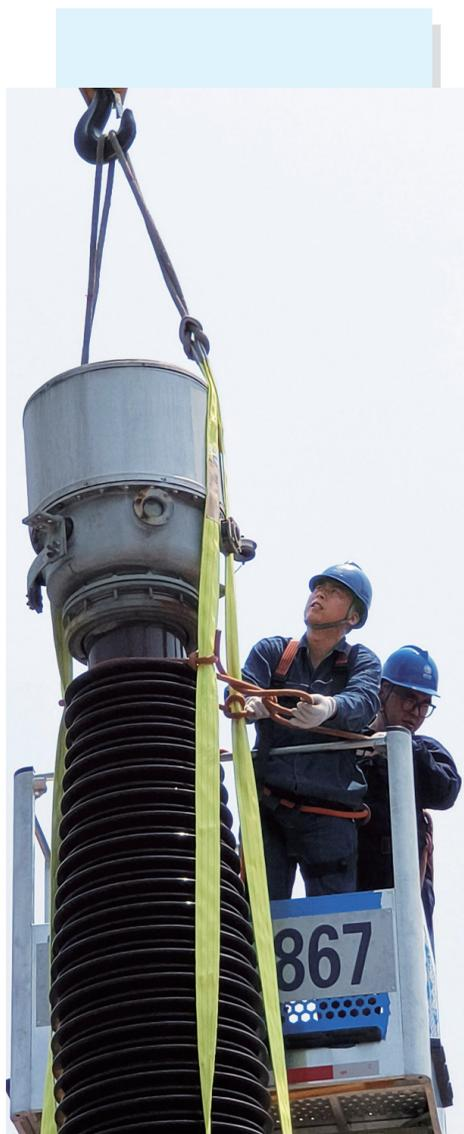
酷热时节,国网白山供电公司变电运检中心的工作人员在更换临江变电站220千伏电流互感器,全力保障高温下电力运行稳定。
