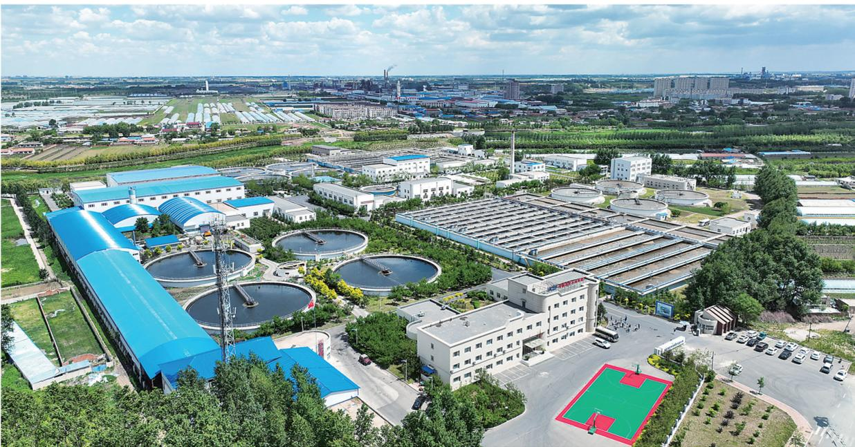
近年来，四平市高度重视生态环境保护，采取“污水处理厂+人工湿地”的治水模式，将城区每日产生的约13万吨污水由四平市污水处理厂处理后，经西湖表流湿地进行再净化，最后流入东辽河的支流条子河，补充河流生态用水。图为四平市污水处理厂全景。
