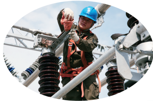
↓ 国网白城供电公司组织专业人员对风电光伏发电项目并网线路开展特巡。
