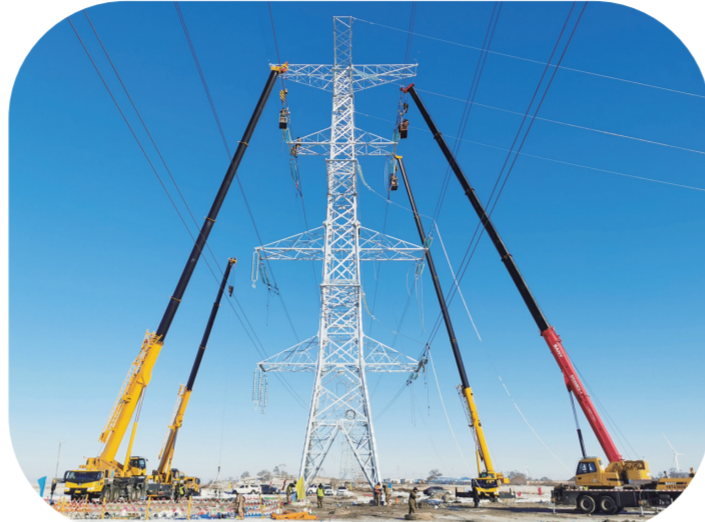
← 国网白城供电公司加紧新能源项目杆塔架设。
