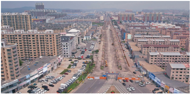
舒兰市舒兰大街南段道路改造及排水工程已全面进场施工。
