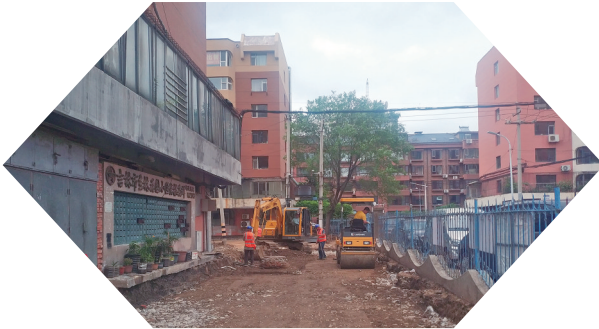
吉林高新区华侨城东林花园小区改造施工现场。
