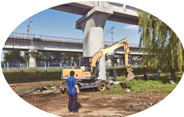
吉林经开区城管执法局清理铁路沿线附近建筑垃圾。
