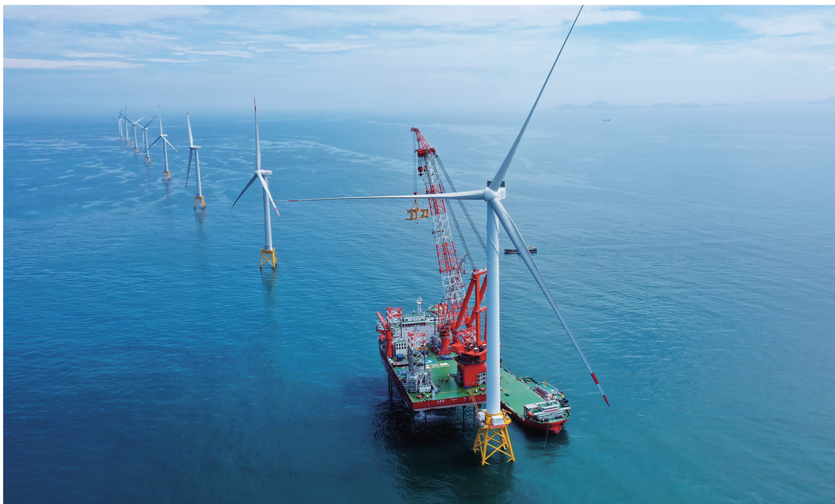
这是16兆瓦超大容量海上风电机组安装完成现场（6月28日摄，无人机照片）。
