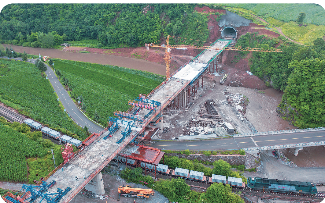
汤河2号大桥完成空中“握手”。杨景霜 陈扬 摄
