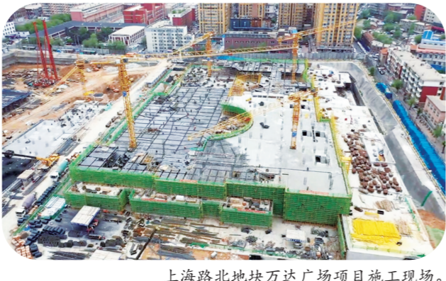
上海路地块万达广场项目施工现场。
