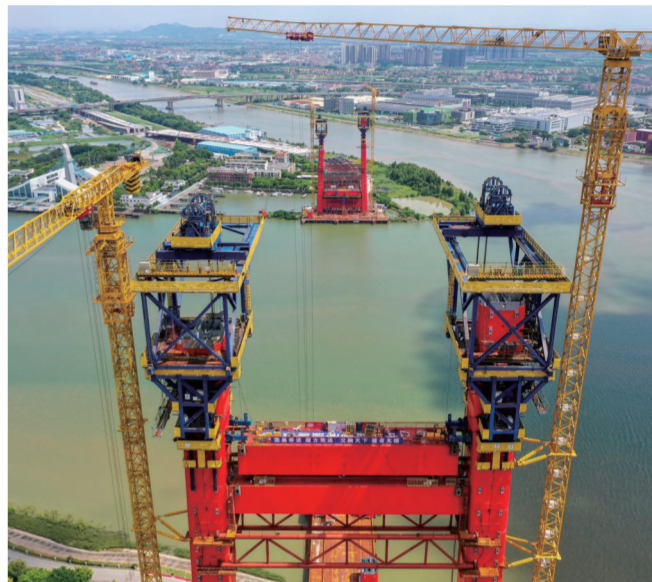
已经完工上横梁吊装的顺德大桥西主塔(无人机照片,8月4日摄)。位于广东佛山市顺德区的顺德大桥是超大跨径钢混组合索塔斜拉桥,由中交路桥承建,主桥全长992.5米,主跨626米,索塔采用变截面H型塔塔,塔高分别为204米、151米。大桥建成后有效打通顺德融入粤港澳大湾区“一小时交通圈”的内部区域道路瓶颈。新华社记者 刘大伟 摄
