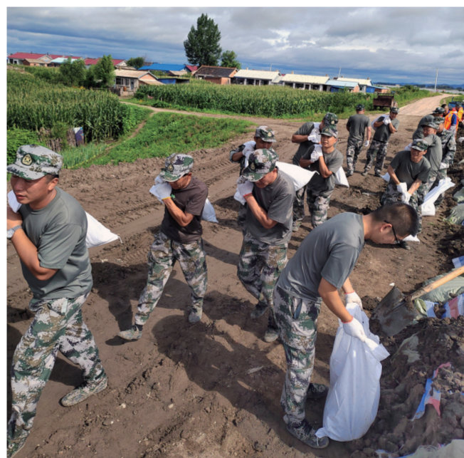
榆树市武装部官兵在弓棚镇加固大堤。
