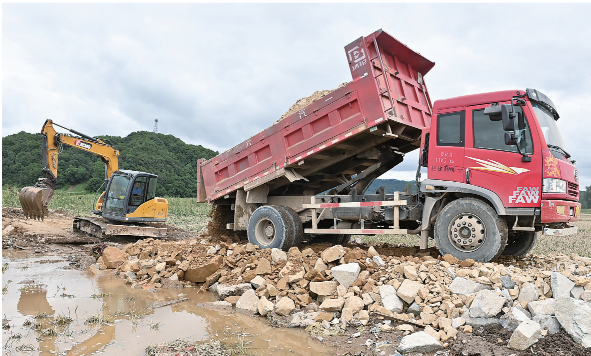
在舒兰市开原镇保安村,交通运输部门正全力抢修水毁路段。
