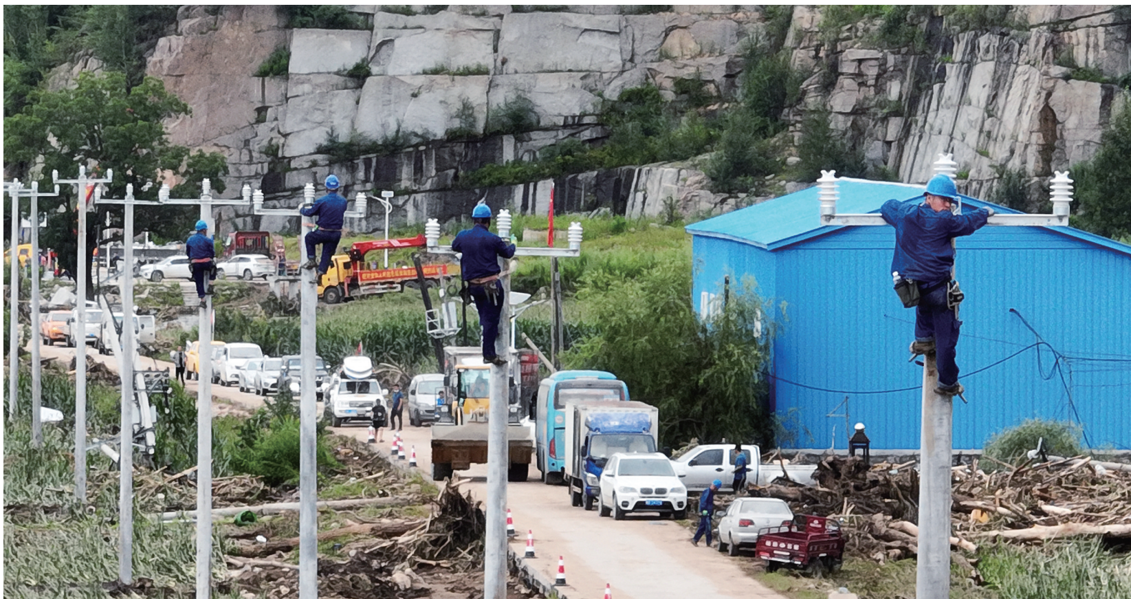
在舒兰市开原镇新开村,国网吉林供电公司抢险突击队对电线杆塔进行灾后抢修。沈泽洲 本报记者 张野 摄
