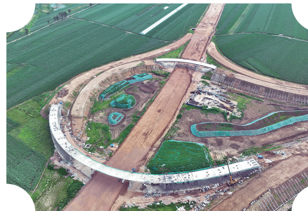
双阳枢纽互通桥梁现浇施工现场。
