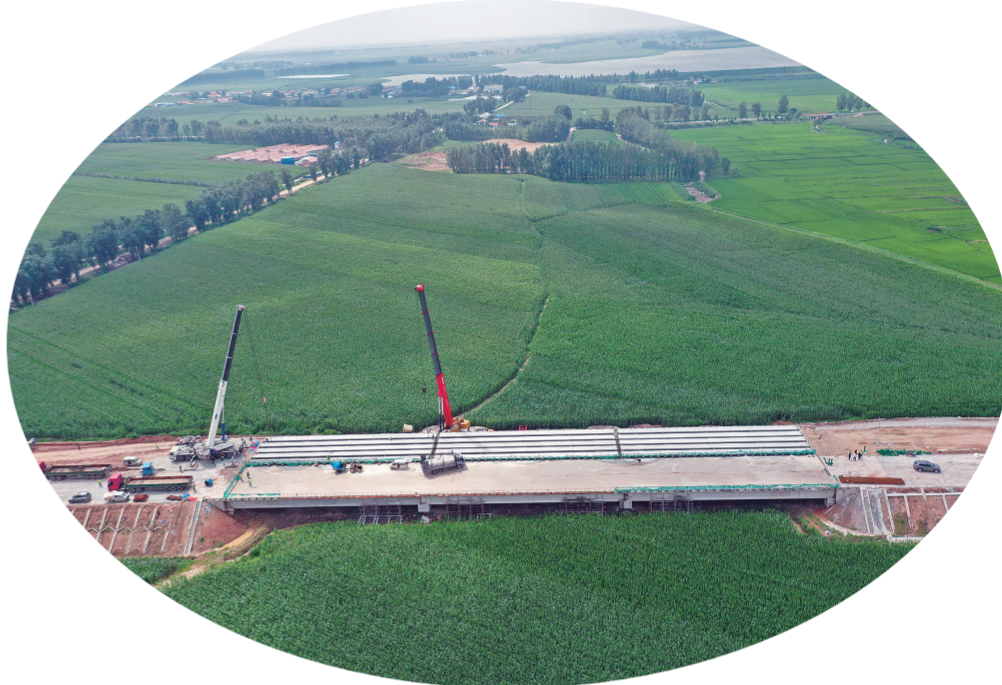
梁板架设现场。
