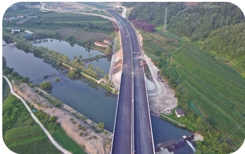
集桓高速02工区太平河2号大桥。
