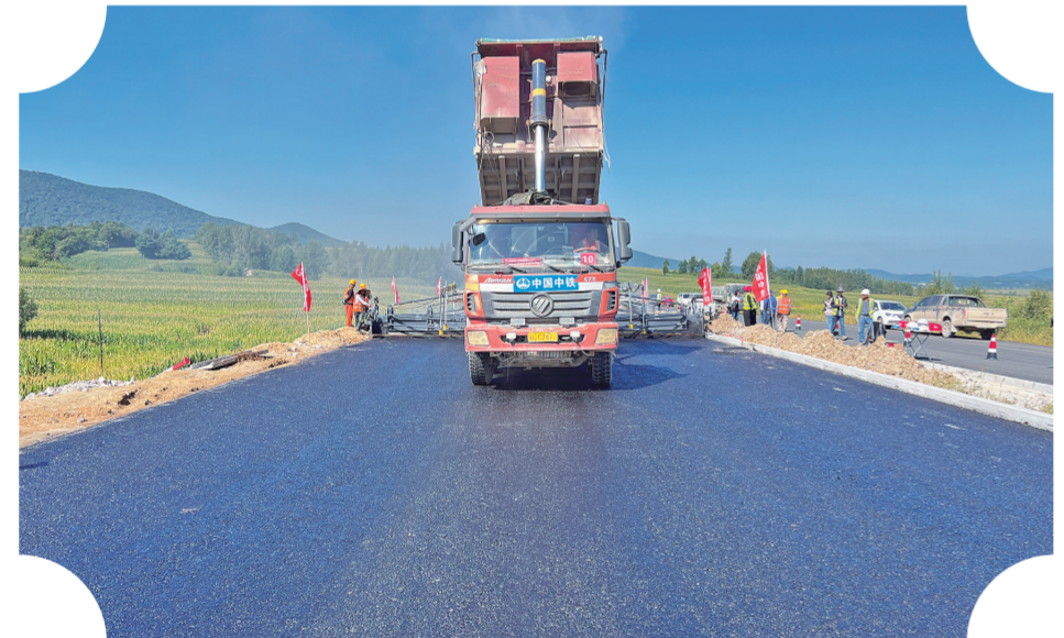
蒲烟高速07工区路面施工。
