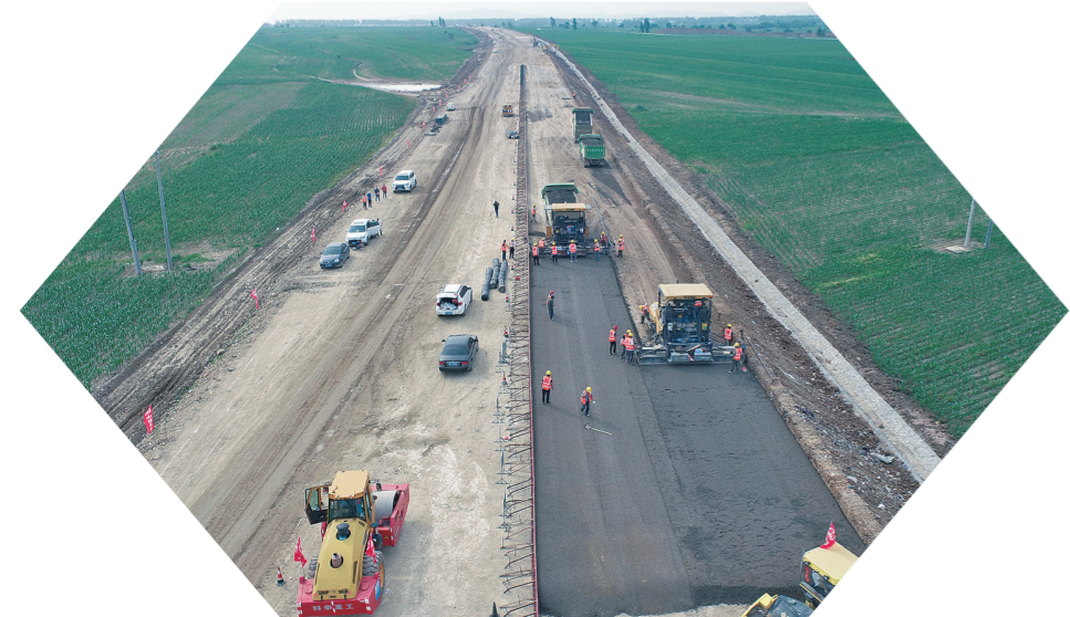
烟长高速02工区路面水稳摊铺。
