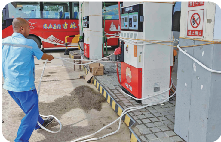
加油站员工紧急加固加油机。
