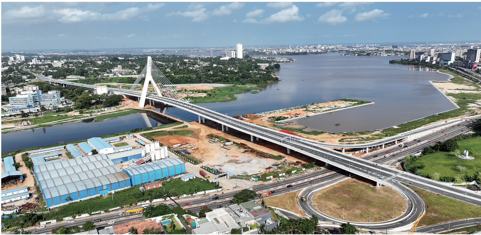
这是7月25日在科特迪瓦经济首都阿比让拍摄的科科迪桥。由中国路桥工程有限责任公司(中国路桥)承建的科科迪桥拉桥项目12日竣工通车。科科迪桥项目主线总长约1.63公里,其中主桥为钢槽梁单塔斜拉形式,全长630米、主跨长200米、主塔高108.6米。
