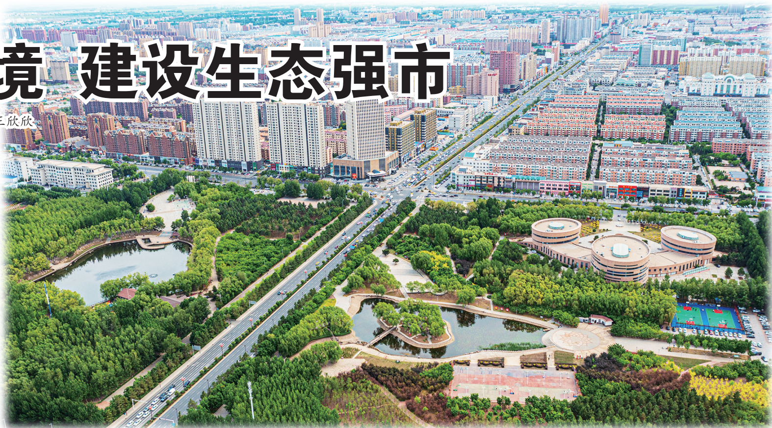
系统化全域推进海绵城市建设。
