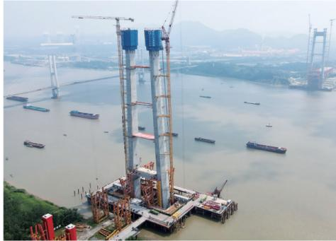
8月18日拍摄的建设中的京台高速铜陵长江公铁大桥，大桥南北两座主塔完成封顶（无人机照片）。当日，由中铁大桥局承建的京台高速铜陵长江公铁大桥3号主塔顺利封顶。
