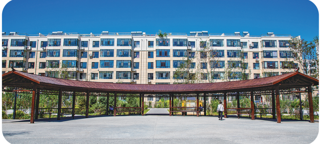
全域推进“海绵城市”建设,改善居民居住、出行环境。图为改造完成的老旧小区。
