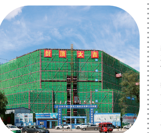
位于船营区的吉林市中心医院省城医质医疗资源扩容下沉建设项目正在进行封顶施工。
