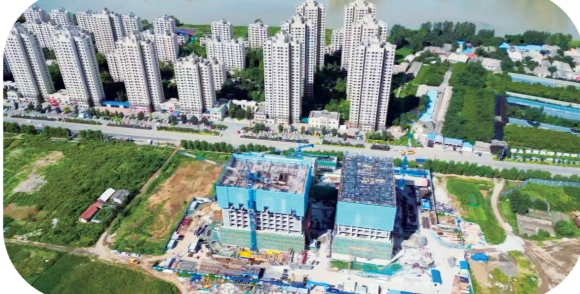
丰满区高科技创新创业孵化园项目。
