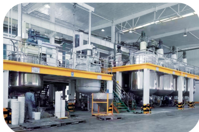
长春顺风新材料有限公司智能化涂料生产车间。
