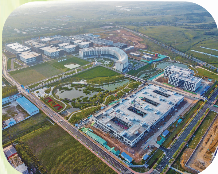
建设中的东丰·国际梅花鹿产业创投园。
