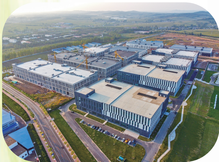
即将竣工的4栋厂房和2栋仓储物流。
