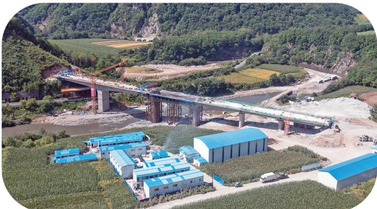
9月1日，由中铁二十三局集团承建的沈白高铁吉林段TJ-6标汤河1号大桥48米T构顺利合龙，为大桥主体工程完工奠定了坚实基础。杨霜霜 陈扬 摄
