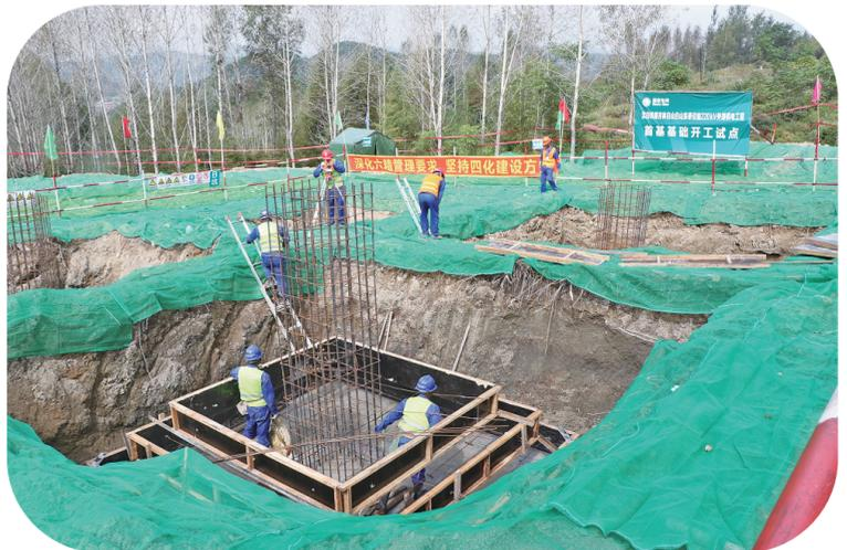
9月5日，沈白高铁白山东牵引站220千伏线路供电工程首基铁塔基础破土动工。作为电力“先行官”，国网白山供电公司将高质量、高标准地加速建设，为沈白高铁如期建成提供可靠电力支持。刘义源 摄
