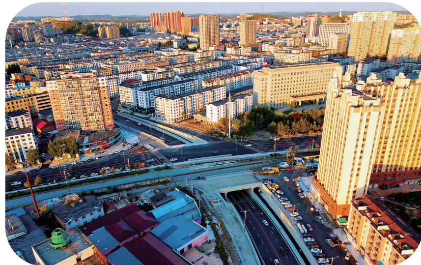
一建道口平改立工程通车后交通更便捷。
