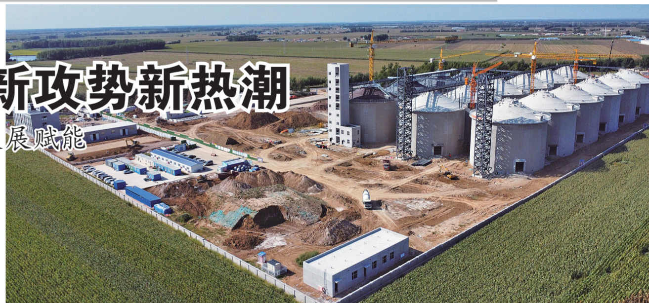
中央储备粮公主岭直属库有限公司粮食仓储项目。
