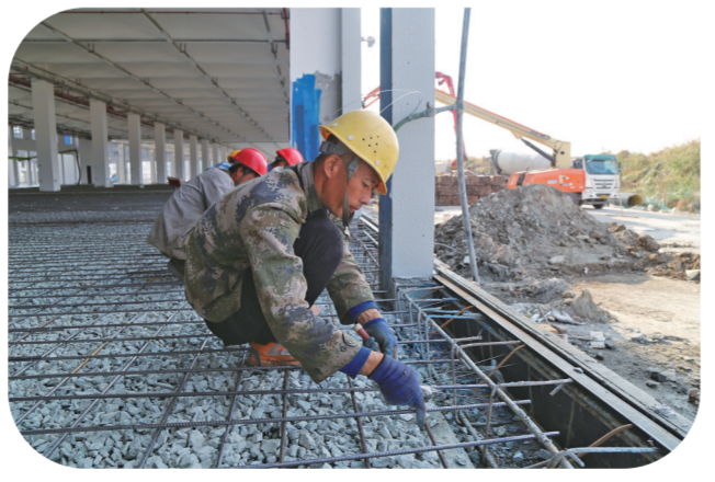
中通快递东北智能电商产业园项目。
