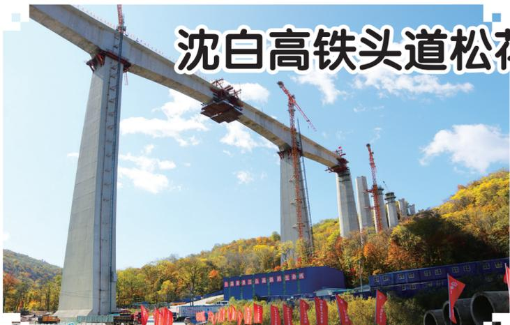
“东北高铁第一高墩”——沈白高铁头道松花江特大桥主桥合龙贯通。王蔚 摄
