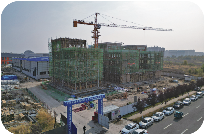
吉林省金祺电子科技有限公司建设项目。
