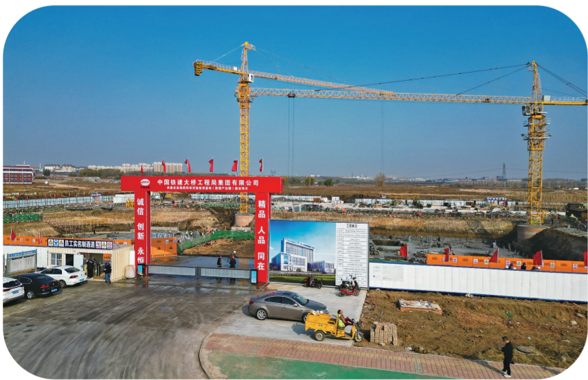
吉高集团科技试验检测基地(数据产业园)项目。
