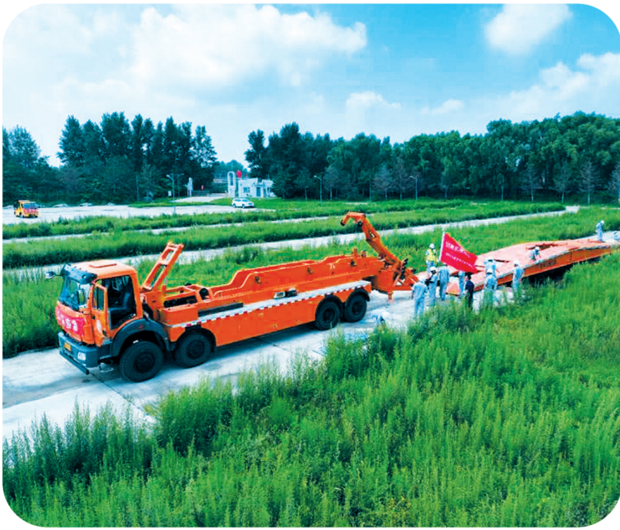
机械化桥梁搭建演练。
