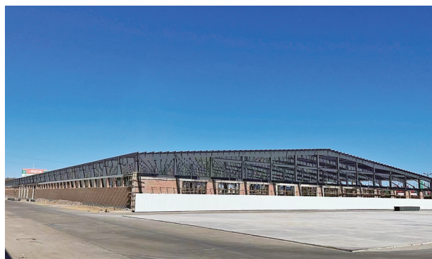
吉林市一网超市食品批发仓储基地项目已完成主体墙体砌筑和钢结构安装。
