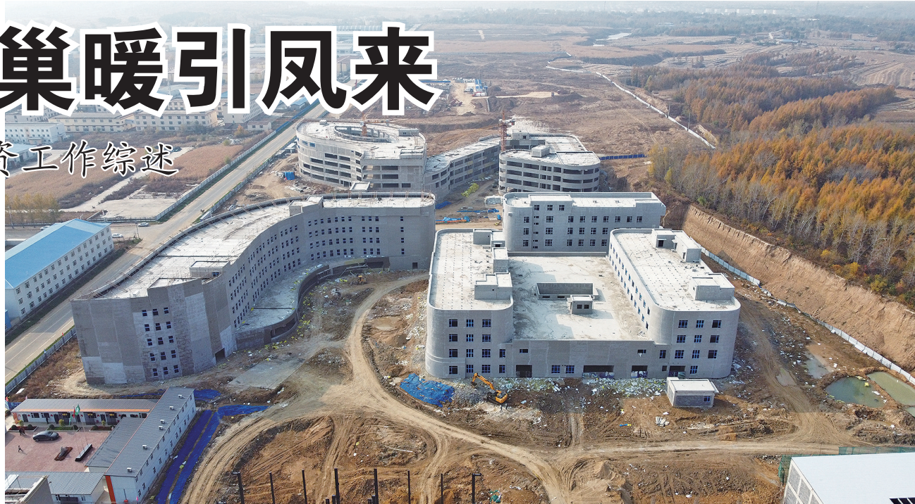
舒兰白鹤产业园项目建设稳步推进。
