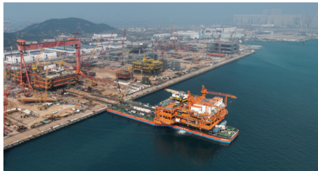
10月26日在青岛建造现场拍摄的埭北油田中心平台（无人机照片）。平台装船后将赴渤海西部海域，进入海上安装和调试阶段。新华社社（杜鹏辉摄）
