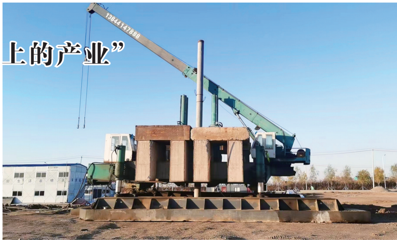
中之杰项目建设场地工程车辆往来穿梭，努力加快建设进度。
