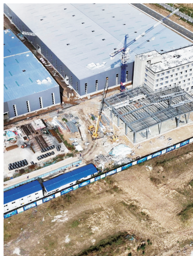
天朗现代农业产业园项目施工现场机器轰鸣，工人全力推进施工。
