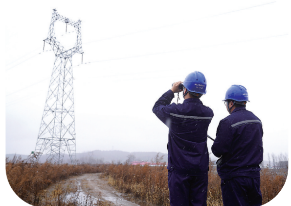
日前，国网辽源供电公司输电运检中心特巡小组尚云龙、范伦铜深入乡村开展雨雪天气特巡特护，检查线路覆冰情况，确保安全供电。 生贺 摄
