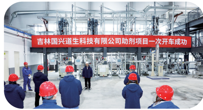
3.5万吨助剂项目现场。
