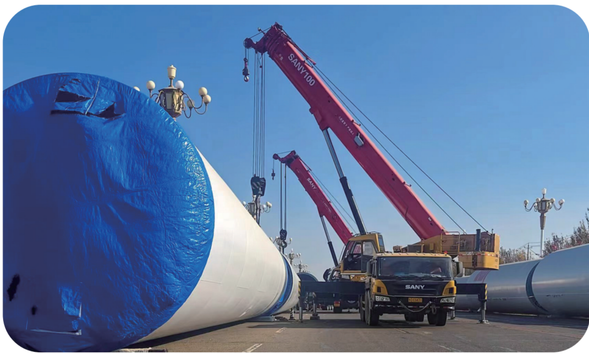
白城洮北绿电产业园以加快建设新能源、新电网、新基建、新工业为主攻方向,打造绿色新材料、绿色装备制造、绿色大数据、绿色食品及医药健康、绿色氢能、绿色化工、绿色冶金等七个特色产业板块,打造我省西部地区生态经济高质量发展新引擎。图为林成风电塔筒工人吊装作业。李广友 摄
