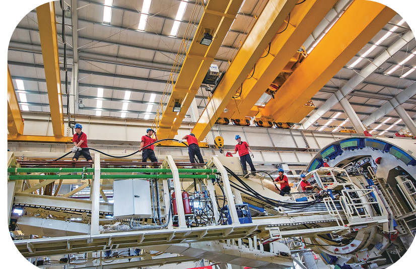
工人们在盾构机上一字排开，将电缆往目标位置输送。
