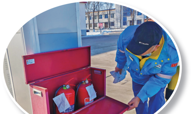
辽源分公司开展消防设备巡检。
