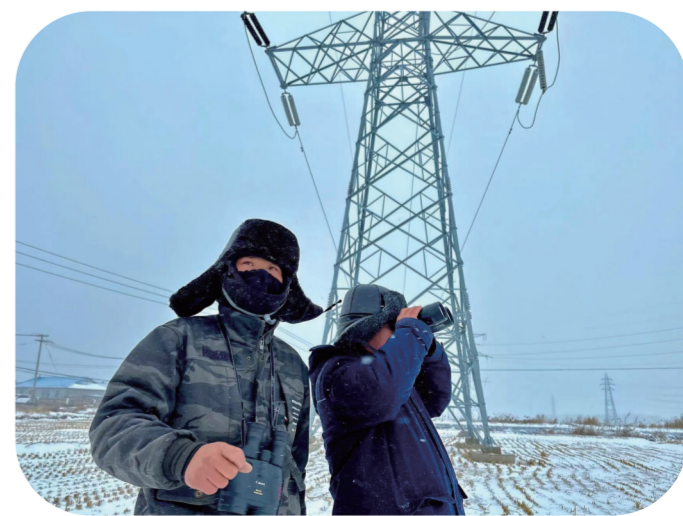
为确保安全供电,日前,国网松原供电公司一线保电人员深入乡村在220千伏农前线61号杆塔附近进行雪中特巡。 吉翔泽 摄
