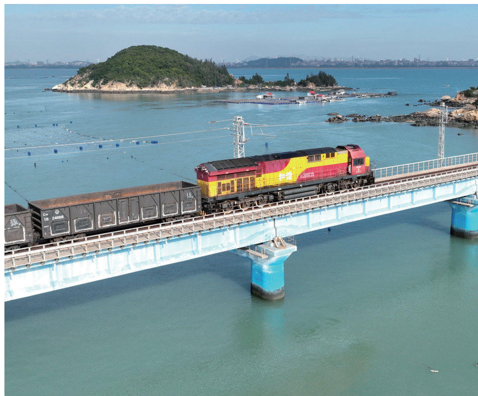
11月29日，装运铁矿石的海铁联运班列经过福建莆田湄洲湾罗屿作业区附近的一座桥梁(无人机照片)。共建“一带一路”倡议提出10周年来，福建规划建设“21世纪海上丝绸之路”重要枢纽，不断开辟“一带一路”新航线，打造“丝路海运”国际综合物流服务平台，加密开行中欧班列，实施海铁联运、多式联运，发挥港口和铁路的中转枢纽效应，打造国内国际双循环枢纽节点，助力发展“一带一路”新通道。
