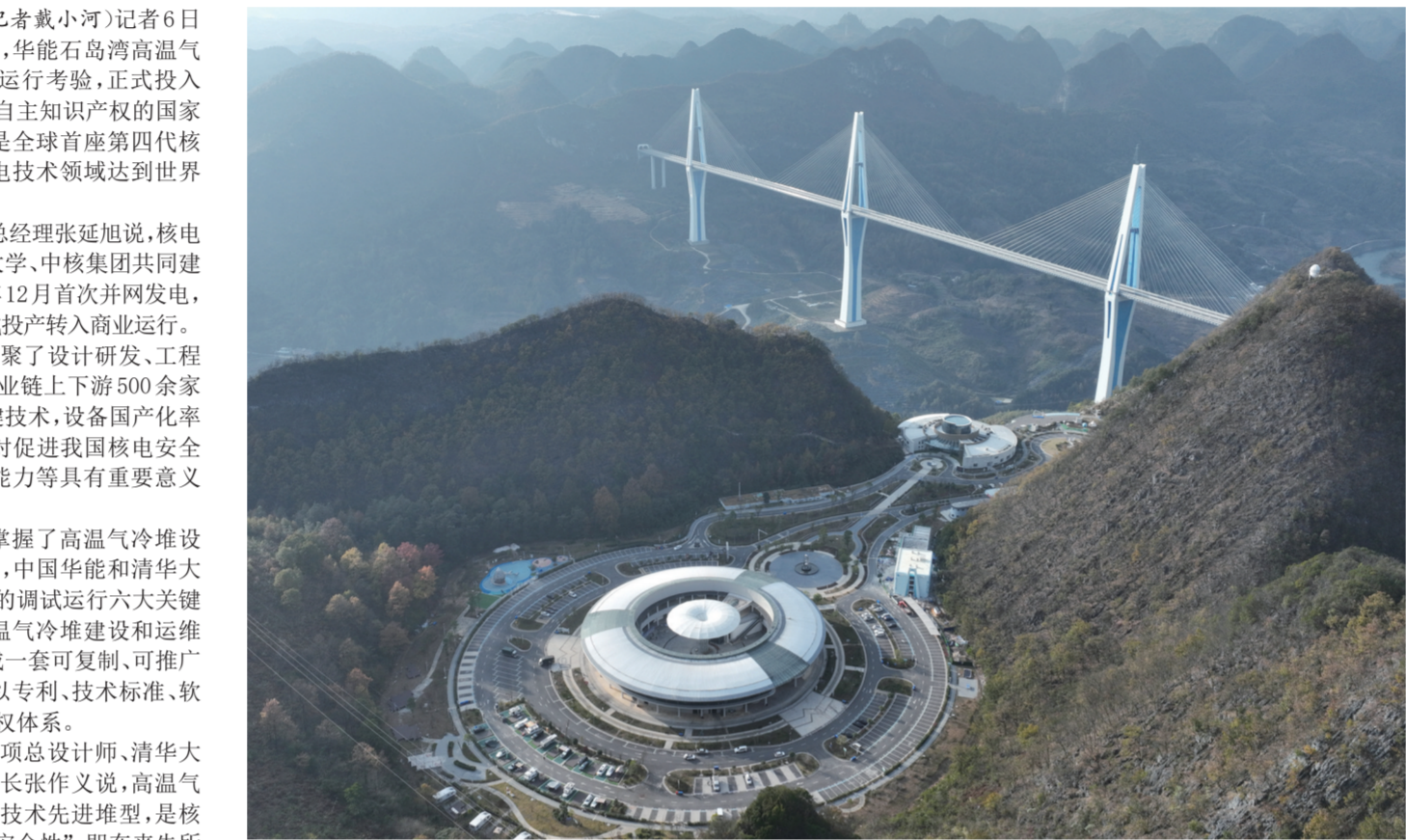
这是12月6日拍摄的贵州省平塘县“天空之桥”服务区和平塘特大桥一景(无人机照片)。初冬时节,在贵州省黔南布依族苗族自治州平塘县,高山峡谷之间的平塘特大桥巍然屹立,自然风光与大桥雄姿吸引了众多游客。
