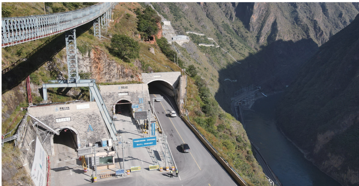
这是雅砻江畔，中国锦屏地下实验室所在的锦屏山隧道口(11月8日摄，无人机照片)。12月7日，中国锦屏地下实验室二期极深地下核低辐射本底前物理实验设施(简称“锦屏大设施”)土建公用工程完工，具备实验条件。这标志着世界最深、最大的极深地下实验室正式投入科学运行。锦屏大设施位于四川省凉山彝族自治州锦屏山地下2400米处，总容积33万立方米。实验室宇宙线通量仅为地表的一亿分之一，是我国开展暗物质研究的绝佳场所。新华社记者 胥冰洁 摄
