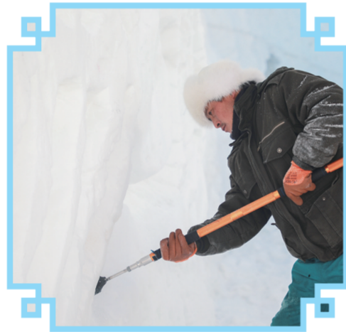
查干湖会展中心冰鱼雪洞奇缘项目施工现场。
