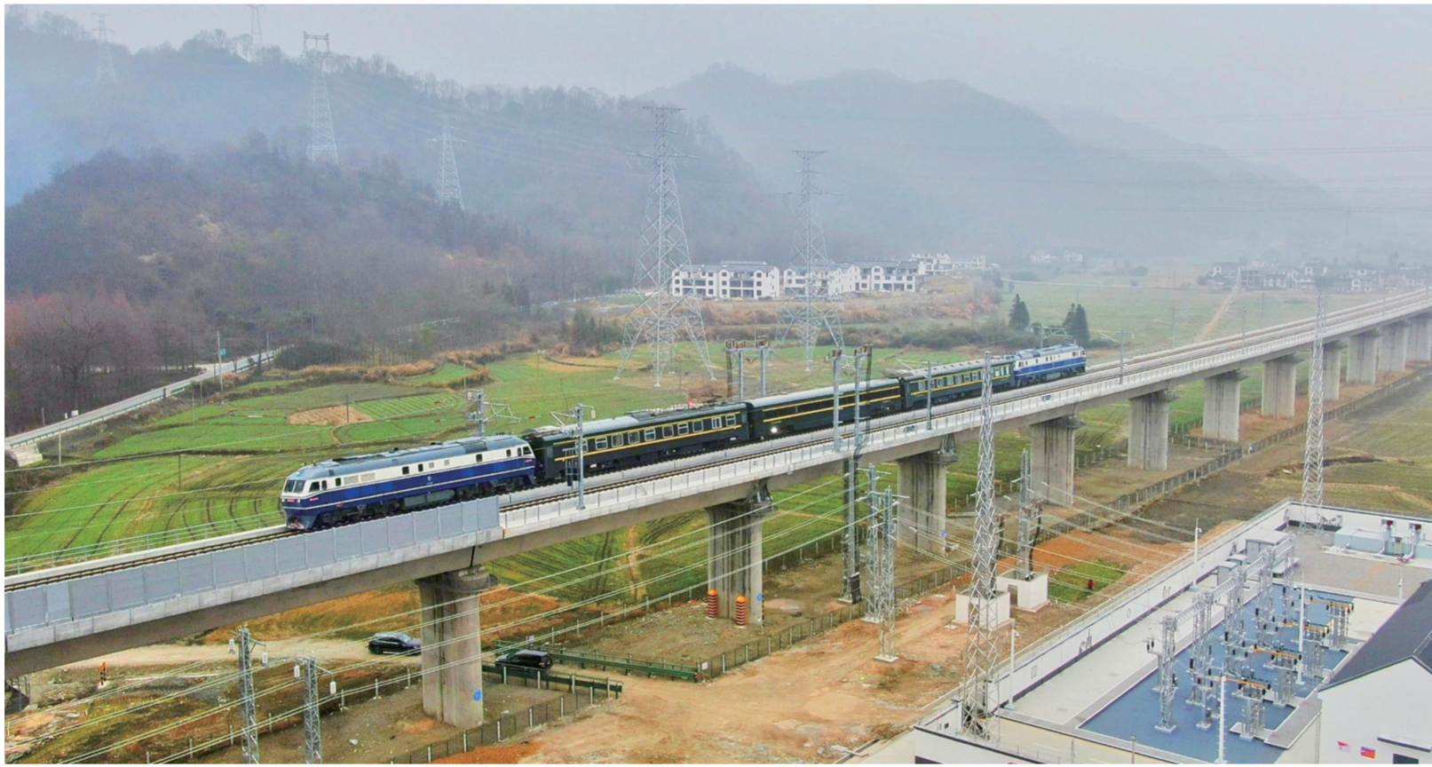
1月15日，检测列车行驶在池黄高铁汤湖特大桥上。当日，池黄高铁联调联试正式启动，全线开通运营进入倒计时。池黄高铁起自安徽池州站，终至安徽黄山黟县东站，正线全长约125公里，设计时速350公里，是武(汉)杭(州)快速铁路通道的重要组成部分。 新华社发(吕金艺摄)
